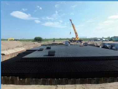
**雨水の流出抑制・有効利用を目的にプラスチック製滞水材を利用した地下貯留・浸透工法。**
