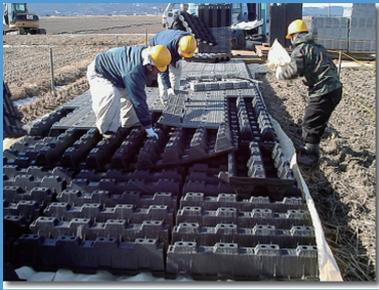
**簡易仮設材として利用、レンタル。残弱地盤でも上部に敷き鉄板を敷くことで重機・車両の通行可能に！**
