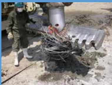
障害物(PC杭等)混在地盤でも そのまま地盤改良施工ができます!
