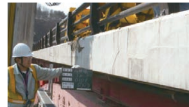
地覆補修時の状況
