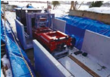
**製品据付機能を付加したPCa製品専用搬送機が施工の合理化を図り、コスト低減、工期短縮に寄与します。**
