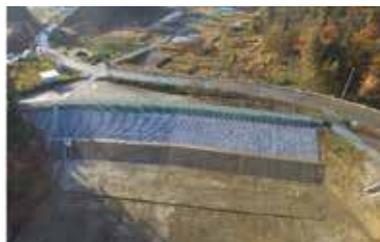
従来、盛土としての利用が不適とされてきた泥土に、繊維質系泥土改良材「ボンファイバー」と固化材を添加・混合することにより、取扱い性の向上（ハンドリング）・高耐久性・耐侵食性および液化化対策の機能を付加した高機能地盤材料として、これらを積極的に再資源化する工法です。生成された改良土は、河川やため池等の堤体盛土、路体盛土、宅地や嵩上げ等の造成盛土に再利用できます。
