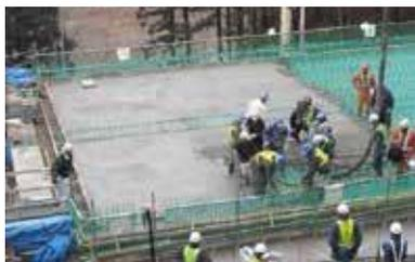
寒冷地における道路橋梁の上部は、凍害や凍結防止剤が散布されることによる塩害による劣化が進行しています。さらにASR抑制に効果があるフライアッシュを使用することで、緻密なコンクリートを形成し、塩分の浸透を抑制させています。秋田県内の公共事業におけるフライアッシュの標準使用が制度化され、能代・山本地域でのフライアッシュの地産地消の流通体系が確立されています。
