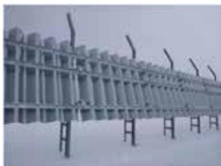
積雪寒冷地では吹雪対策として路側に設置できる吹き払い柵が広く用いられています。しかし、吹き払い柵は構造上、風が柵に対して斜めから入射する場合や、柵の下部間隙が閉塞した場合に、防雪効果が低下します。そこで、風が柵に対して斜めから入射する場合や、暴風雪等によって柵の下部間隙が閉塞した場合にも粘り強く防雪効果を維持するよう、1枚板の波形状の防雪板で構成される「斜風対応型吹き払い柵」を開発しました。
