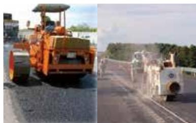
めざまし舗装とは、アスファルト舗装の表層施工時、特殊加工ローラーにより表層の路肩部分に一定間隔で連続した凹部を形成し、ドライバーに注意を促す舗装です。居眠りしている車両が道路外に逸脱しそうになった時、凹部を走行することにより振動・騒音が発生し、運転者の注意を喚起し未然に事故を抑えることができます。
