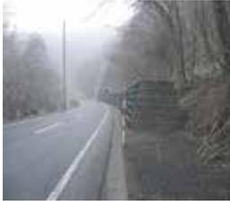
ジオロックウォールは、特殊繊維で補強した土の擁壁により落石や崩落土砂を防護する工法です。衝撃エネルギーの大部分を柔構造の壁体内部で吸収するので地盤改良を必要としないケースが多いこと、道路際など設置スペースが限られている現場への対応力が高いこと、落石などで部分的に破損して該当箇所だけを容易に補修できることなどが主な特徴です。現地発生土を有効活用できることや構造体そのものを緑化できることなど、環境性能の向上にも寄与しています。
