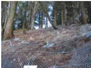
ロープ付鉄筋挿入工法は、2枚のプレート(支圧板・固定板)、ロープ、ナット等で法面工を構成。補強材と一体化(連結)、法面工の機能である補強効果、表層土の拘束、補強材間の中抜けを防止するものである。鉄筋挿入工という概念は、補強土工という概念に包摂される。在来植物を生かした全面緑化工法であり、数年経過後、この法面工は植生が枯死して土壌化した表層土に胚胎される。供用期間後は自然界にあるFeOとなり、異物とはならない。在来植物を生かす理由は、経済性以外に、自然環境の保全、降雨による浸食防止、根の土壌緊縛力による凍上崩落の抑制がある。
