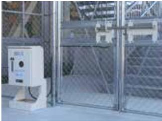
**2012年消防庁特別賞を受賞した「防災BOX」を組み込んだ自動解錠扉。電気不要で停電でも稼働します。**
