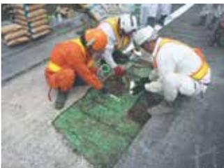
『ボンド床版断面修復システム』は、コンクリート床版に発生したポットホール補修において、微細ひび割れの含浸補強と断面修復用モルタルの打継接着を行う工法です。ブレーカーなどによる研り作業を行った補修対象箇所に対して、研り器具の打撃によって生じた微細なひび割れの含浸補強を目的とした『ボンド マイクロクラック補修用プライマー』を事前に塗布し、さらに断面修復モルタルとの打継接着を目的とした『ボンドE2000』を塗布して床版とより強固に一体化を図る工法です。製品容量はロス込みで1㎡分となっており、施工管理が容易となり作業の効率化も図れます。
