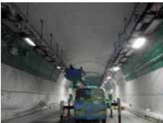
『トンネル覆工コンクリートはく落防止工法』は、覆工コンクリートのはく落による第3者災害を未然に防止することを目的とした工法です。覆工コンクリート面に対して連続繊維シートを接着剤で強固に被覆し、覆工コンクリートのはく落を防止します。はく落が想定される覆工コンクリート片の大きさや、はく落面積、部位によって適宜材料の仕様を選択することができ、現場の様々な状況に対応することが可能です。また、トンネル内の火災事故を想定した延焼性・自己消火性試験や火災時の燃焼時に発生するガスの安全性を確認した工法です。
