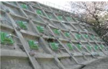
EHDアンカーは、PC鋼より線の各素線間までエポキシ樹脂を充填した耐久性の高い引張り材「付着型ECFストランド」を使用し簡素な構造でありながら水密性を高めて高耐久性を実現しました。
