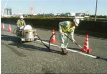
道路舗装の劣化抑制には路盤への水の浸透を抑制する必要があります。シール材注入工法は、ひび割れにシール材を注入することにより雨水の浸透を防ぐとともにひび割れの成長を抑制し、舗装寿命の延命化を図るものです。クラックシールNXは、従来のシール材より耐久性を高め土木研究所の規格(案)にも適合したアスファルト系の加熱注入型シール材で、路盤の保護により舗装寿命を延命し、補修コストを縮減することのできる材料です。
