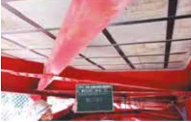
宇田関連素材や航空機の機体材、ゴルフクラブでもお馴染みの「炭素繊維」を用いた、まったく新しい補強・補修の技術。炭素繊維は、鉄の約10倍相当の引っ張り強さを備え、また質量は鉄の約1/40(同強度比)と非常に軽いのが特徴。この炭素繊維の集成板を高性能エポキシ樹脂接着剤によって母材に接着する本工法により、従来の作業にかかっていたコストを大幅に削減することを可能にした。
