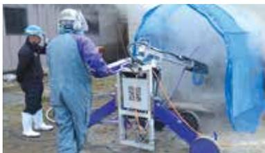
鉄筋に損傷をほとんど与えることなく、コンクリートのハツリ工事を行います。コンクリートブレーカーのような振動や騒音も少なく、マイクロクラックの発生がほとんどないので付着力を維持できます。
