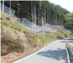
ARC (アーク) フェンスは、100KJまでの小規模落石エネルギーに対応する落石防護柵です。金網の変形、及びワイヤーロープと緩衝金具の摩擦より、落石の衝撃力を吸収します。支柱間隔を地形に合わせた配置ができ、立木を避けた設置が可能で、伐採を最小限に抑えることができます。雪崩予防柵として改良したARCフェンスSタイプもあり、落石の危険がある積雪斜面など、これまでの雪崩予防柵よりも適用可能な箇所が拡大しています。ARCフェンスは累計480件以上の実績を誇り、平成28年にMade in 新潟プラチナ技術に認定されました。様々な現場で安全を創造し続ける信頼の落石防護柵・雪崩予防兼用柵です。
