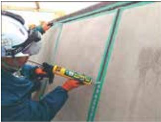
『ボンド 土木用シール極』は、主に土木コンクリート目地やコンクリート2次製品目地、農業用水路などの接合部の目地などに使用する高耐候性シーリング材です。強靱なゴム弾性を有し、目地の伸縮に長期間追従します。また、塗装材との付着性がよく、ほとんど汚染を生じません。1液型タイプで材料の計量・混合の必要がなく、施工管理が容易となり作業の効率化が図れます。
