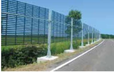
樹脂製のベルトを格子状に組み合わせたネットを利用し、従来製品より軽量コンパクトな構造になりました。コスト削減はもちろんのこと、原材料や運搬時のCO<sub>2</sub>排出量が削減された環境に優しいフェンスです。高所作業が不要となるため、施工時の安全性向上、作業員の負担軽減等作業環境改善を図れます。加工し易くフレキシブルな樹脂の特性を利用して、さまざまなバリエーションにより道路や各種施設を風や雪から守り、より安全で快適な環境を実現します。
