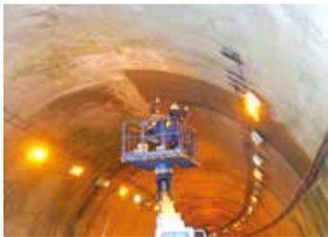
コンクリート剥落防止には一般に有機系接着材が使用されているが、可燃性のためトンネル内で使用することは不向きである。橋梁等外部に使用する場合は、紫外線による劣化があるため保護材が必要。
