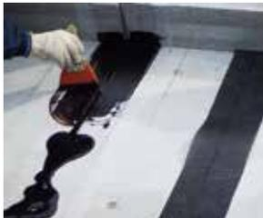
ONEPIECE-GEL SYSTEM工法は、アスファルト乳剤の同系材料のONEPIECE-GEL JOINT (伸縮装置材) とONEPIECE-GEL PROOF (床版防水材) を使用することによって、塗膜系床版防水工と埋設型伸縮装置設置工の簡易・短時間での施工を実現し、床版防水層と遊間部充填材を一体化させることで橋梁の伸縮装置機能と防水機能を保つ工法です。
