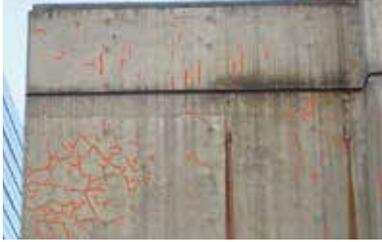
橋梁等のコンクリート構造物を対象に、その定量的把握および経過観察を精密かつ効率的に行うためのひび割れ自動検出技術やパノラマ合成技術の開発を行っている。我々が開発したひび割れ自動検出技術は、従来技術に比べ見落としが少ないことはもちろん、汚れや型枠跡の誤認識が非常に少ないことが特徴である。これらの要素技術は、クラウドサービスとして提供可能な形態でシステム化しており、オフィスだけでなく点検現場でも結果の閲覧や操作が可能である。開発は、首都高技術株式会社、東北大学との連携のもと、ニーズ調査や実証評価を行いながら進めている。
