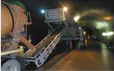
連続鉄筋コンクリート舗装は、工事車線で鉄筋の組立作業が必要となることから、生コン材料は通行車線からの供給となり、現道工事等については一般通行への規制が生じ通行車線を常時確保することが困難となります。
