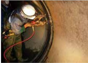
**サンタック | N-ジョイントは既設管渠を内面より耐震性管路に改修する止水可とう継手です。**
