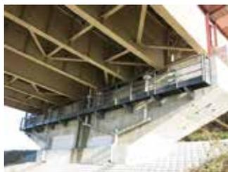
インフラ整備保守を目的とした従来の鋼製の橋梁検査路は海岸や融雪剤散布地域などで素材の腐食が進行し、転落事故等の危険が懸念される状況にありました。本製品は材料にGFRPを採用し、従来製品に比べ大幅な耐久性の向上と軽量化を実現しました。建設費や維持費が削減できトータルコスト(ライフサイクルコスト)を削減します。NETIS登録番号：TH-160017-A
