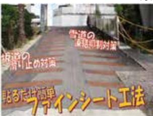
『ファインシート工法』は、路面に貼り付けるタイプの滑り止め舗装工法です。冬季には氷が張りにくくなることから、ブラックアイスバーン対策にも有効です。
