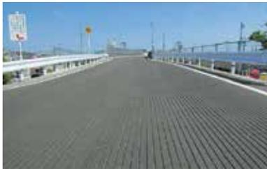
車両のスリップによる飛び出し、多重衝突事故の未然防止工法として多くの実績を上げています。設置場所の環境・予測される事故に応じて、溝の幅、深さ、間隔などを効果的に組合せることにより、多様なパターンでの事故抑止対策が図れます。積雪寒冷地域の路面凍結抑制と融雪促進により冬期のスリップ事故防止対策として有効で、冬期道路の維持管理費を大幅に軽減します。
