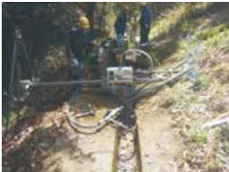
法面（盛土・切土）での水抜き管設置が容易にでき、軽量コンパクトで人力での現場搬入・搬出・移動が出来ます。
