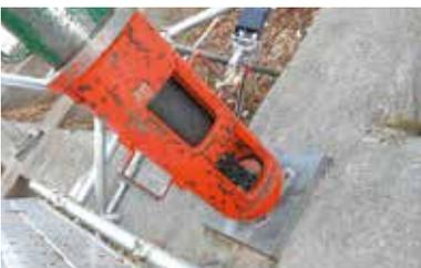
グラウンドアンカーが日本に導入され50年が経過し、グラウンドアンカーの老朽化による性能低下が確認されています。これらのグラウンドアンカーの多くは「旧タイプアンカー」であり現在の永久アンカーに比べると防食性能に問題があります。旧タイプアンカーを点検・調査し、現在のアンカーと同等の防食性能まで向上させる技術が求められています。グラウンドアンカーにおける不具合が発生する箇所の90%以上は頭部・頭部背面と言われています。これらを補修する事で、現在のグラウンドアンカーと同等の防食性能まで向上させる事が可能です。
