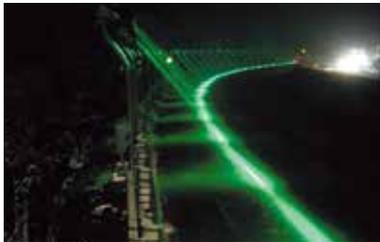
帯状ガイドライトは、外側線の位置を連続的な線状の光で明示し、視程障害時におけるドライバーの安全性や安心感を高めます。
