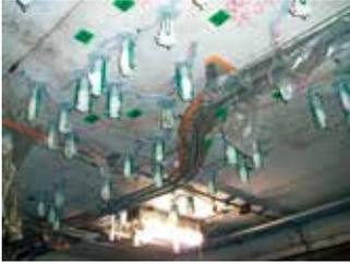
『ボンド E2601』は、水中でも硬化するエポキシ樹脂であり、コンクリートのひび割れ注入用接着剤です。水中環境下や湿潤状態のひび割れ部でも乾燥を待たずにひび割れ補修工事の施工が可能となります。また、飲料水関係規格（厚生省15号）に適合しており、水道施設や農業用水路等のコンクリート構造物の補修に安全・安心に使用できます。
