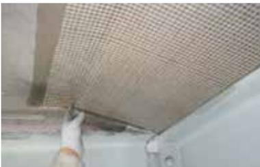
業界初の無機系接着剤(TSボンド40Sクリア)と繊維メッシュシートを複合使用した剥落防止工法。
