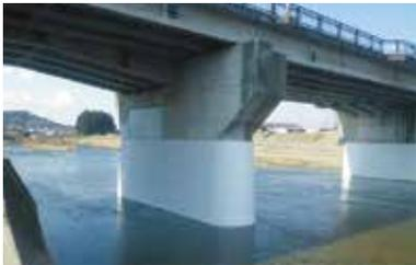
AT-P工法とは既設RC橋脚の表面に溝を刻み、軸方向補強主鉄筋を埋め込みエポキシ樹脂で固定後、補強帯鉄筋を表面に配置してポリマーセメントモルタルで巻立てる工法である。補強断面厚さは、補強帯鉄筋が18mmの場合で34mm（最小）。補強主鉄筋は橋脚内に埋め込まれるため、サイズに関わらず補強断面の厚さに影響しない。使用する補強帯鉄筋の最外径にポリマーセメントモルタルの被り厚（15mm）を加えた厚さが補強断面厚さになる。水門の堰柱、底版の他、樋門の函体補強などの施工例が多数ある。
