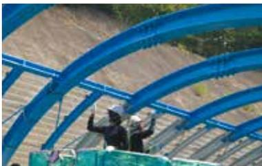
塩害環境等における鋼構造物の塗替え塗装において、残存錆中の劣化因子（塩化物イオン等）により、比較的早い時期に再劣化に至ることが問題になっている。CSCシステムは、鉄筋コンクリートの塩害対策で実績のある「SSI工法」の考え方を応用して、鋼構造物を塩害環境等の腐食を抑制する画期的な防錆塗装システム。通常のケレン作業では除去しきれない孔食部の腐食性物質に対し、下塗材に配合した塩分吸着剤が直接作用して、イオン交換反応により塩化物イオンを吸着・低減し、代わりに亜硝酸イオンを放出することにより、孔食部の腐食性を低減する。
