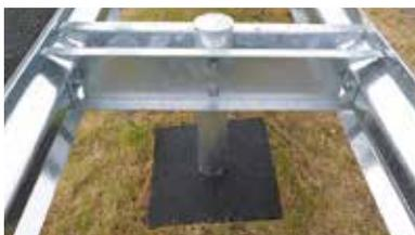
ポールガードは、ガードレールや標識、道路照明等の支柱周りの雑草を抑制し、支柱周りの草刈り作業の軽減や草刈り機による事故、支柱の損傷を防ぐための防草マットです。
