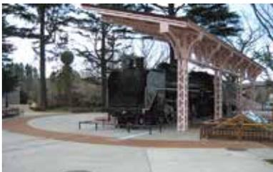
ポーラスな舗装表面はすべりにくく、透水機能、平坦性にも優れており安全・快適な通行ができます。また、透水性アスファルト舗装と比べ、耐流動性、耐油性にも優れ、交通荷重による空隙つぶれがなく、雑草や芝生の侵入により舗装版が壊れることもありません。
