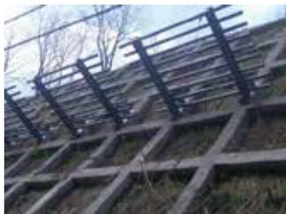
従来の鋼製雪崩予防柵は重量物である為、通常は揚重機による搬入・設置が行われており、揚重機の入ることのできない箇所への設置は索道による材料搬入や、大人数での人力施工で対応されてきました。本製品は構造部材にGFRPを使用することにより、従来の鋼製品に比べて総重量を1/2以下に軽減することが出来ます。さらに人力搬入・施工が可能な重量まで分割が可能である為、揚重機の使用できない場所でも搬入・施工が可能となります。NETIS登録番号：TH-140014-A
