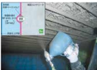
近年、飛来塩分や凍結防止材などに由来する塩化物イオンがコンクリート構造物に浸入し、鉄筋が腐食する塩害が問題となっている。SSI工法は、錆やコンクリート中に含まれる塩化物イオンに直接作用する「塩分吸着剤」を活用した断面修復工法で、抜本的な塩害対策が可能となる。鉄筋ケレン作業では除去しきれなかった錆や躯体に含まれる塩化物イオンを、イオン交換反応により塩分吸着剤が吸着・低減し、代わりに亜硝酸イオンを放出することにより、鉄筋周辺を腐食環境から防錆環境へと改善して、長期耐久性を回復する。
