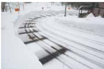
「地中熱」は足元に眠るもっとも身近な再生可能エネルギーです。その熱エネルギーは深さ15～20m程度で10～16℃ほど。この熱エネルギーをヒートパイプで直接採熱し、路面の融雪に利用するのが「地中熱ヒートパイプ融雪システム」です。システム構造はシンプルで、深さ20m程度のボーリング孔に数本のヒートパイプを挿入するだけです。このヒートパイプは、降雪や気温低下により路面が冷却され、地中と路面との間に一定以上の温度差が生じると自動的に作動し、地中熱エネルギーを路面に運びます。そのため、地中熱以外の一切のエネルギー、一切の制御機器も使用せずに融雪を行うことができます。
