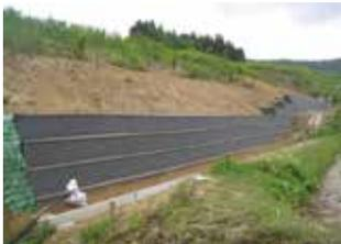
AZエルバリアは従来のふとんかご工法に代わる新工法です。構造が単純なので普通作業員でも簡単に施工可能で、工期が短縮できます。材料が軽量なので大型重機を必要とせず、人力作業が可能のため、狭小地でも施工が簡単です。中詰材には現地発生土、碎石、割栗石などを充填できることから湧水対策、法面緑化も可能です。材質には、亜鉛-10%アルミニウム合金めっき仕様のφ6mm鉄線(サンAZワイヤー)を使用し、耐食性は溶融亜鉛めっきの約2.5倍の耐久性を持ちます。災害復旧にも迅速に対応できる工法です。
