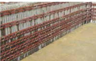
KJS工法用緊張装置を使用することで、適性試験および確認試験とアンカー一定着を連続して行うことが可能である。アンカーの構成部品が少なく簡素である。
