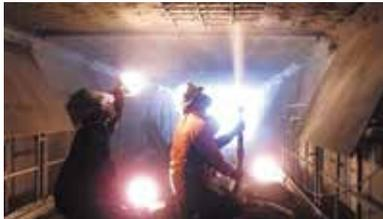
大規模地震の発生が危惧される中、既設の橋脚等において耐震補強が喫緊の課題となっている。本工法は、補強鉄筋として高強度鉄筋を配置した後、ポリマーセメントモルタルを乾式吹付けにて巻立てて一体化させることで、耐震性能を向上させる工法である。
