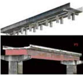
橋梁や高架橋を市販の高性能一眼レフカメラで撮影するスクリーニング技術です。近接目視点検と画像スクリーニング技術を併用することで、高精度の変状展開図と日常管理効率の向上を実現しています。
