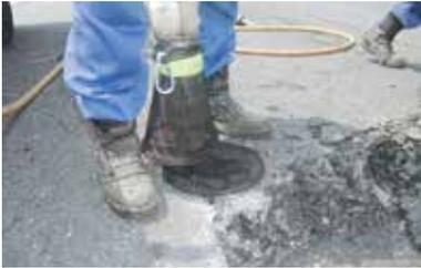
ブレーカーでのハツリ作業等では、ハツリ片が飛散して第三者や作業者に当たってしまう危険性があります。このハツリガードは、ブレーカーに簡単に取り付けられ、コンパクトで持ち運びに便利で、メッシュ素材を使用しているためノミ先を目視出来るので作業性も高いまま使用可能です。
