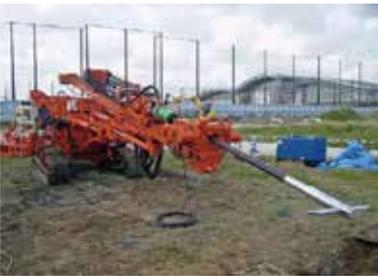
WinBLADE工法は、地中で開閉可能な攪拌翼を使用して原位置土とセメントスラリーを攪拌混合することにより、ソイルセメントコラムを造成する『地中攪翼型 機械式攪拌工法』です。
