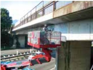
『ボンドKEEPメンテ工法VM-3』は、コンクリート表面をビニロン製3軸ネットと特殊変成したポリウレタ樹脂で強固に被覆し、コンクリート片のはく落を防止する工法です。従来の適合工法では、作業できなかった氷点下環境の低温域（-5～5℃）での作業を可能とし、さらに速硬化・省工程を実現し、最短施工日数が2日の画期的な工法です。また、通年使用可能な材料を採用しており、季節（気温）に応じて材料の切り替えが不要となり施工管理、工程管理が容易となります。2成分型エポキシ樹脂を使用していないため、従来工法と比較してかぶれにくく作業環境の向上にも貢献します。
