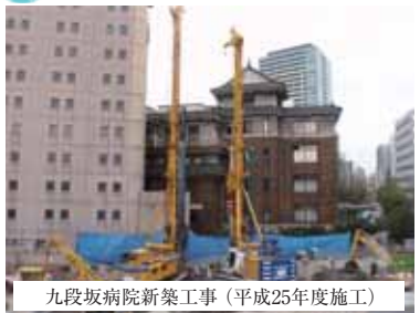
九段坂病院新築工事(平成25年度施工)
