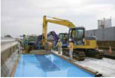
コンクリート床版上の施工事例
