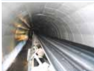
ベルコントンネル補強
