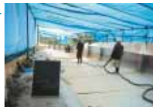
現場発泡ウレタン施工状況
