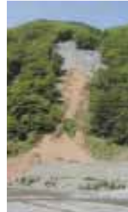
山腹工における法面保護工例 (直高 170m 圧送距離 380m)
