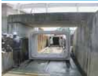
マルチ搬送機工法・マルチレベル工法併用に依る搬送状況
