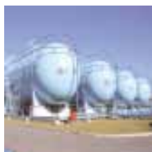
三河湾ガスターミナル(株)「LPG 貯蔵タンク」
