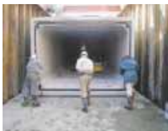
マルチレベル工法・ボールに依る前後・左右調整作業
