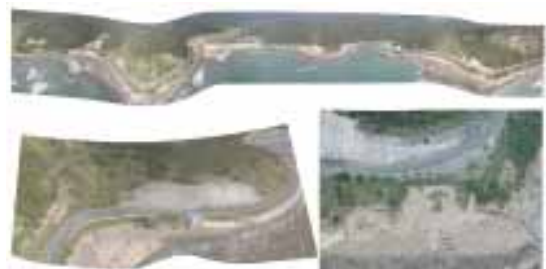
台風通過直後の被災状況撮影事例
