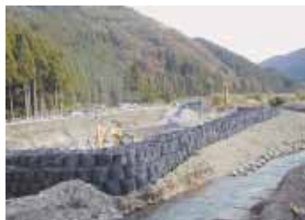
施工例：仮締切工
