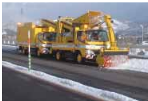
橋梁高架部の狭小路肩部除雪
