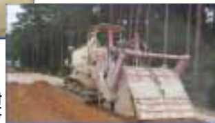
岩手県下閉伊郡田野畑村 横木沢道路舗装工事
