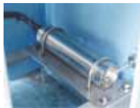
ゲート取付型内外水位差計センサー
