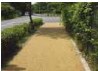
仙台市太白区 太白団地入口 歩道舗装
