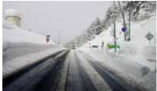
国道 398 号 山谷トンネル付近
