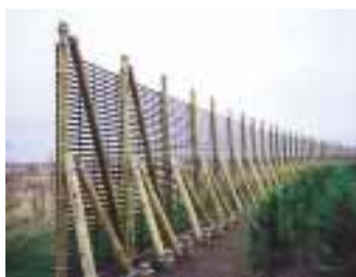
木柱型（防雪・防風林の植樹保護）
