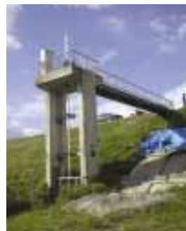
樋門・樋管例
