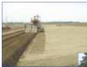
青森県上北郡六戸町 堤防用遮水材ブレード工事
