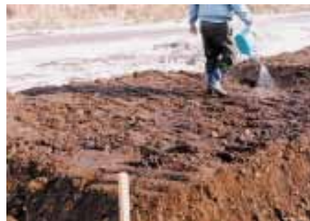
凍結防止剤散布状況
