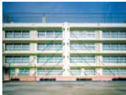
耐震補強工事が完成した聖学院小学校校舎(東京都北区)
