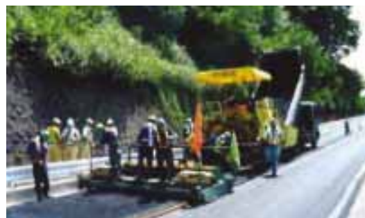
ゴム粒子散布機を用いた施工状況
