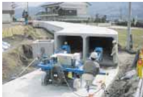
施工状況（ハング式）
