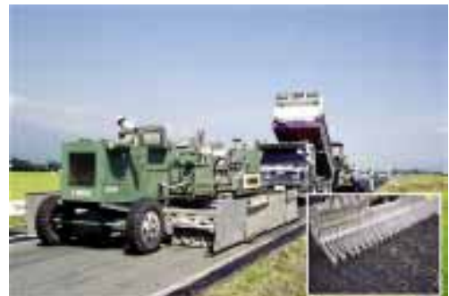
ヒートスティック工法の施工状況
