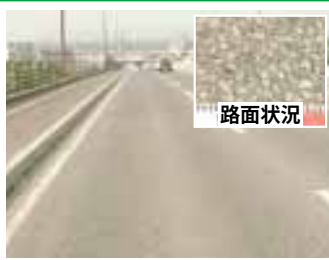
橋面舗装への適用例 (S 61 施工)
