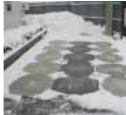
電気面状発熱体利用融雪パネル駐車場応用例
