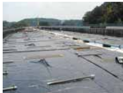
橋梁スラブへのアクアマット敷設状況
