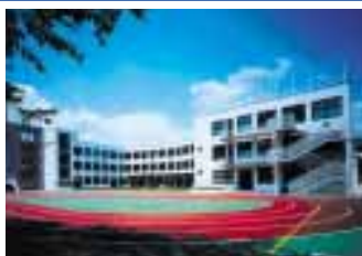
港区立高輪台小学校（東京都港区）〈耐震壁、鉄骨ブレース、制震装置の新設、柱・梁炭素繊維巻き付け〉
