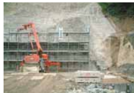
濁沢第六砂防堰堤工事
