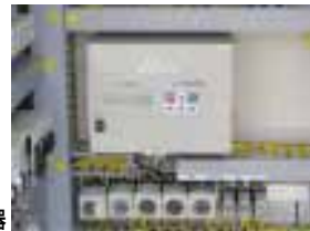
ゲート取付型内外水位差計変換器
