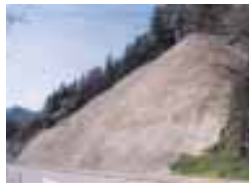
釜石法面防災工事 施工前
