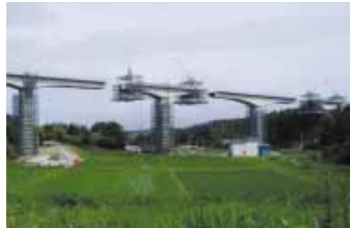
常磐自動車道・前田川橋の張出し架設状況
