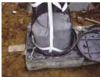
浸透槽内への設置状況
