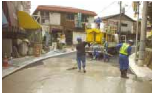
横浜市 施工状況
