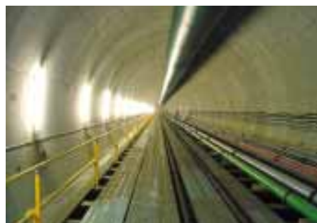
仕上がり状況
