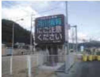
施工事例：中部地方整備局 丸山ダム管理所 殿
