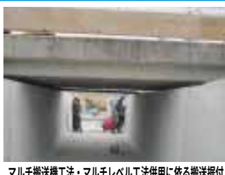
マルチ搬送機工法・マルチレベル工法併用に依る搬送据付 橋梁下端との空隙 約10cm
