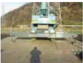
土シート+クロスウェーブ2段+敷鉄板φ22mm 25tラフタークレーンが載っても破損・潰れ無し
