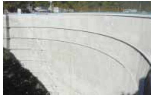
ダム堤体補修工事
