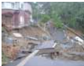
宅地の地震被害例
