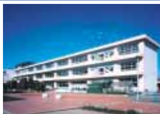
つくば市立荃崎第一小学校（茨城県つくば市）〈鉄骨ブレースの新設〉
