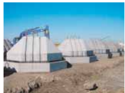
石炭灰を利用した硬化体「ケルプベース」
