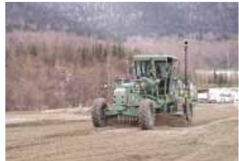
高精度GPSと3D-MCを利用した施工状況
