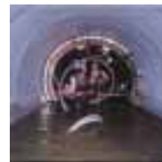
図 円形管施工状況
