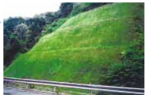
山形県 土木部 平成16年度 一般県道左沢浮島線道路改良工事
