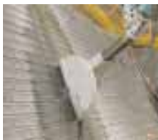
ブロック積擁壁斜め切断状況
