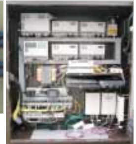
光スイッチ接続・設置状況
