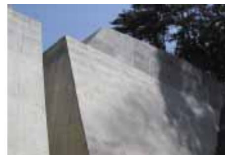
盛岡地方振興局土木部 中の沢筋新山地区都市対策砂防工事 ピアスタイプに SUS ボルトプレートを使用しイメージアップを図った例
