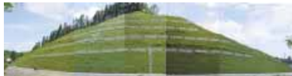
沢田道路改良工事（青森） 施工後1年
