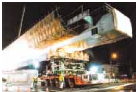
ドリーを用いた交差点内夜間一括架設
