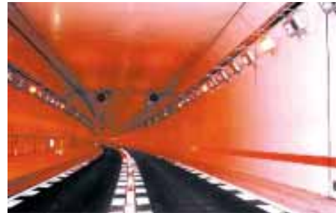
三河港湾工事事務所 衣浦トンネル塗装工事
