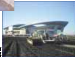
埼玉県さいたま市 調整池超軟弱土処理工事
