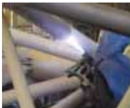
常温金属溶射作業状況(水管橋)
