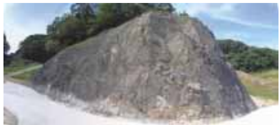
国土交通省 打込地区湖面進入路整備工事（鹿児島県）
