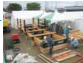
施工状況（人力）
