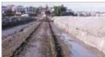
宮城県仙台市 天沼公園整備工事
