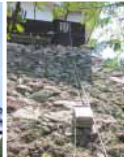
レーダー探査による 石垣背面調査
