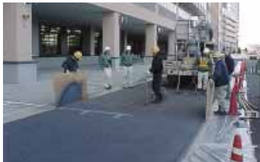
埼玉郵便局 施工状況
