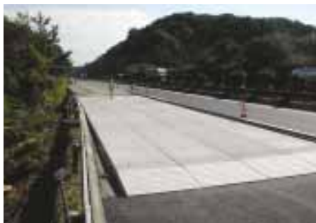
H15.10 東名集中工事（横断BOX 沈下対策）
