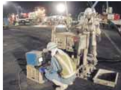
CPG 施工状況=モルタル圧入締固め
