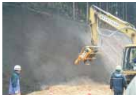
回転式吹付ノズル「シゲル君」による吹きつけ状況
