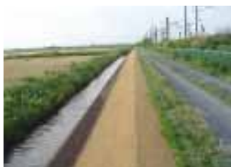
宮城県田尻町大沢地区 江合川沿岸土地改良区 法面防草
