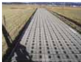
東北電力送電線工事：仮設道路として水田への使用例
