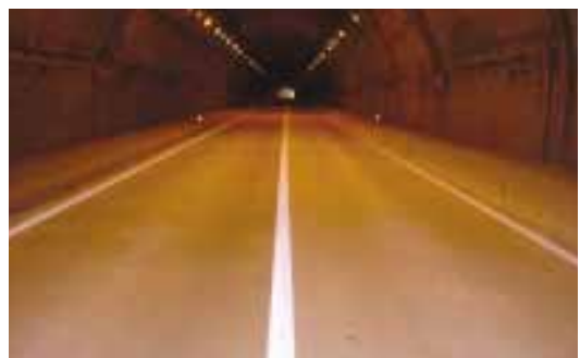
一般国道112号・砂子関トンネル
