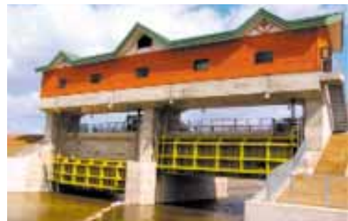
能代工事事務所 摩当川水門ゲート塗装工事
