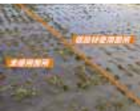
土シート+クロスウェーブ2段+敷鉄板φ22mm 25tラフタークレーンが載っても破損・潰れ無し
