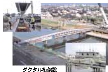
ダクトアル桁架設
