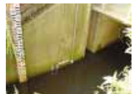
流速・流向計設置例
