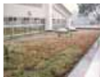
厚さ 5 cm の軽量緑化基盤マットを用いた小学校屋上緑化
