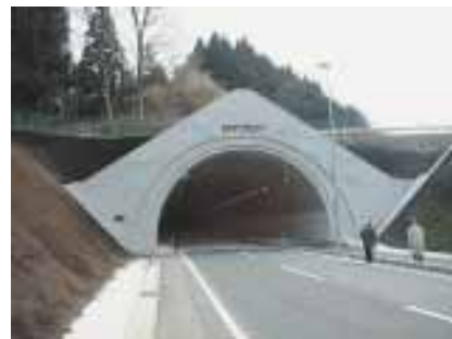
福島県川俣町 口太山トンネル内装工
