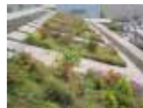
修理工場スレート屋根に軽量緑化基盤マットを用いた樹木併用緑化
