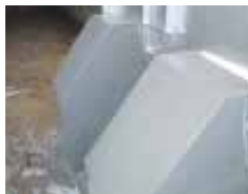
コンクリート保護工
