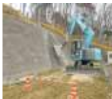
ブロック積擁壁斜め切断状況
