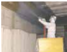
橋梁剥落防止工事
