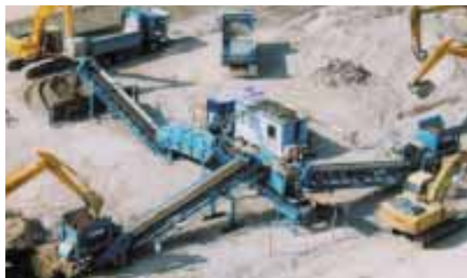
万能土質改良機による建設発生土再利用システムの全景
