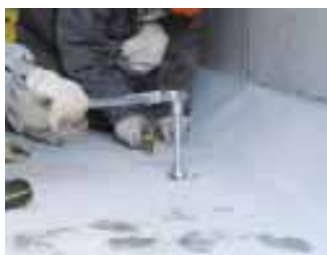
マルチレベル工法・レンチに依る上下微調整作業
