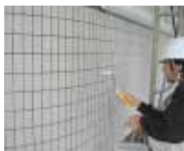
磁器タイルにローラーで施工可能
