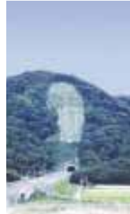
トンネル抗口上部の法面保護工例 (直高 130m 圧送距離 220m)
