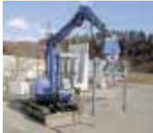
押し込み型マッスルワイヤーソーイング工法
