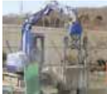
押し込み型マッスルワイヤーソーイング工法
