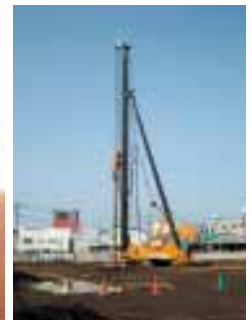
DOG工法施工状況
