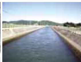
導水路 補修事例
