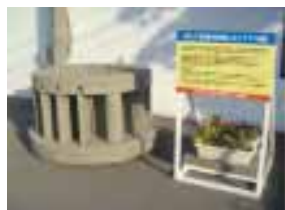
魚礁の展示品(実物大) 全 高=1.0m 頂版径=1.6m 底版径=1.8m 重 量 2.5t
