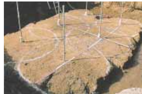
改良体の造成状況（Φ3m）
